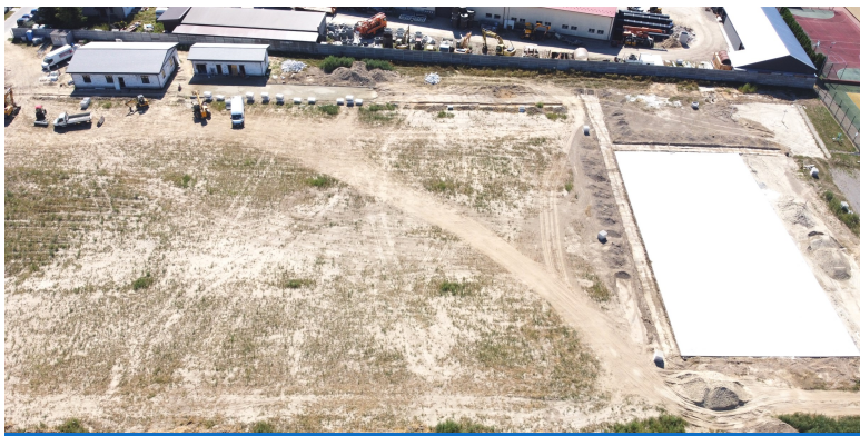
Teren kompleksu w trakcie budowy
