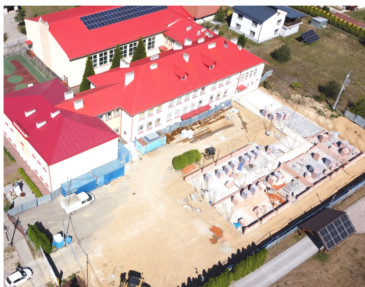
Teren budowy nowego skrzydła budynku
