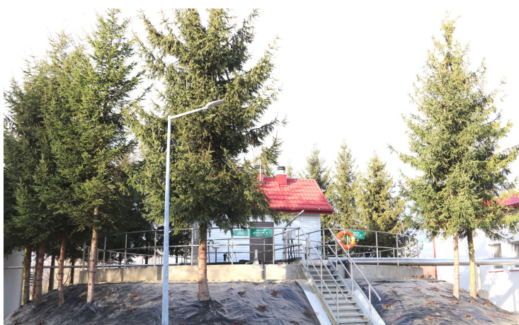
Oczyszczalnia ścieków po modernizacji
