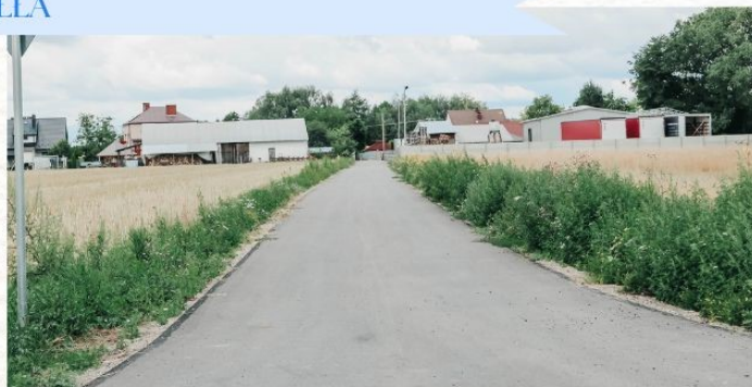
Przebudowana droga w stronę cmentarza
