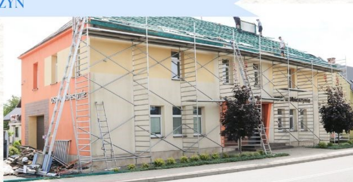
Wymiana pokrycia dachowego na budynku WDK
