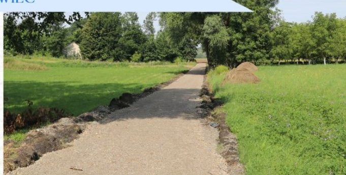
Dudki (w trakcie remontu)
