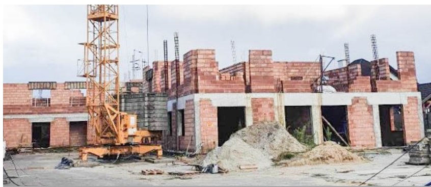
Nowe skrzydło w trakcie budowy
