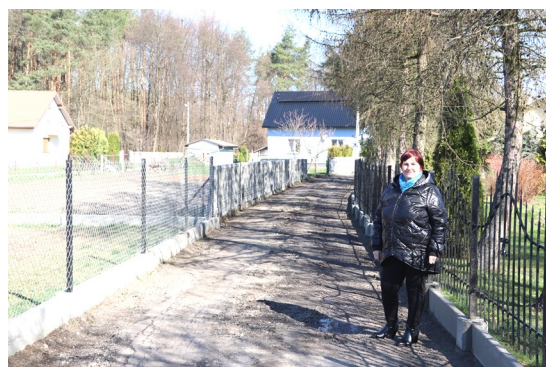
Remont drogi w Wólce Ogryzkowej
