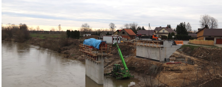
Most w trakcie budowy
