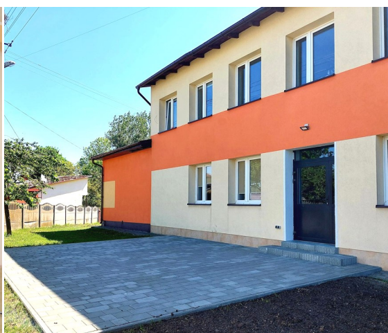
Budowa tarasu przy WDK w Gorzycach
