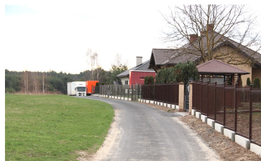
Remont drogi w Gn. Tryn.
