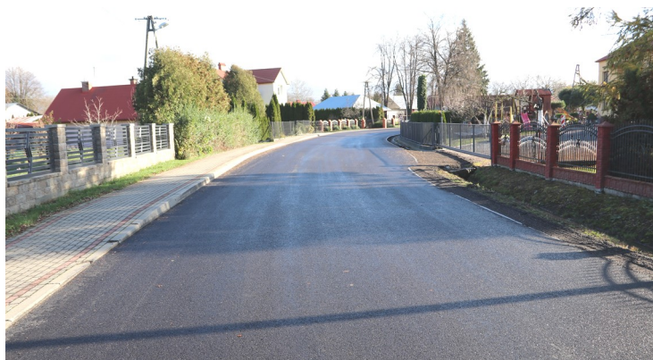
Droga powiatowa w Ubieszynie
