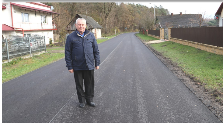
Droga powiatowa w Małej Jagielle
