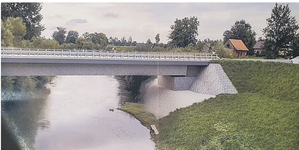
Budowa mostu na Wisłoku.
