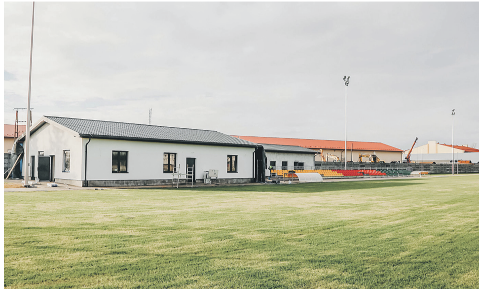
Budowa kompleksu sportowego w Tryńczy.
