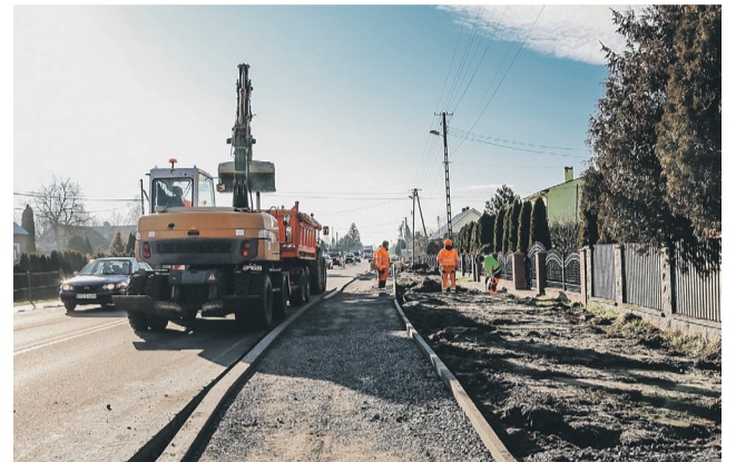
Budowa ścieżki rowerowej w Gniewczynie Łańcuckiej.
