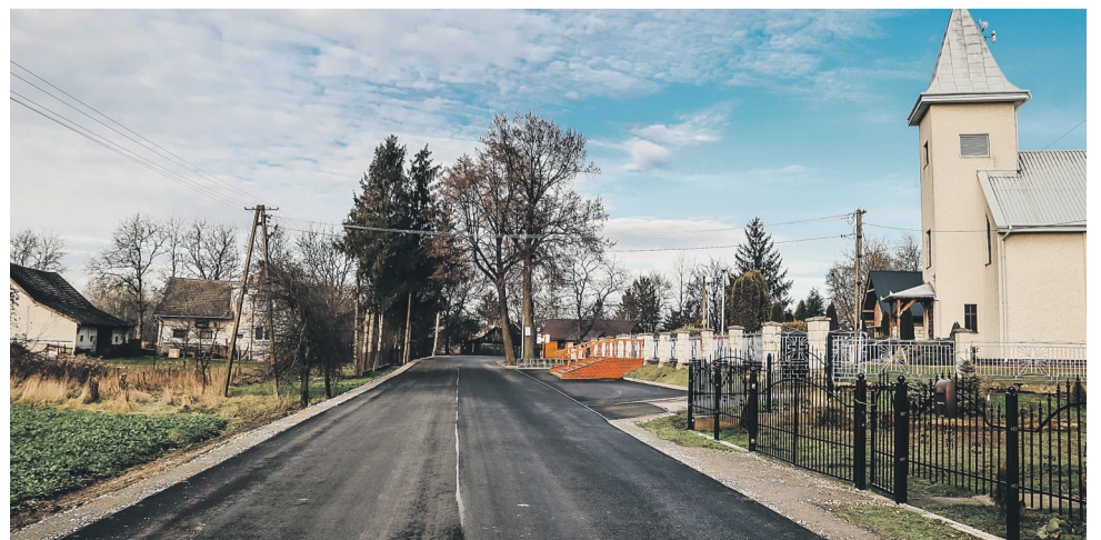
Remont drogi powiatowej w Głogowcu.
