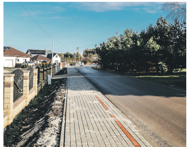
Budowa chodnika w Gorzycach.
