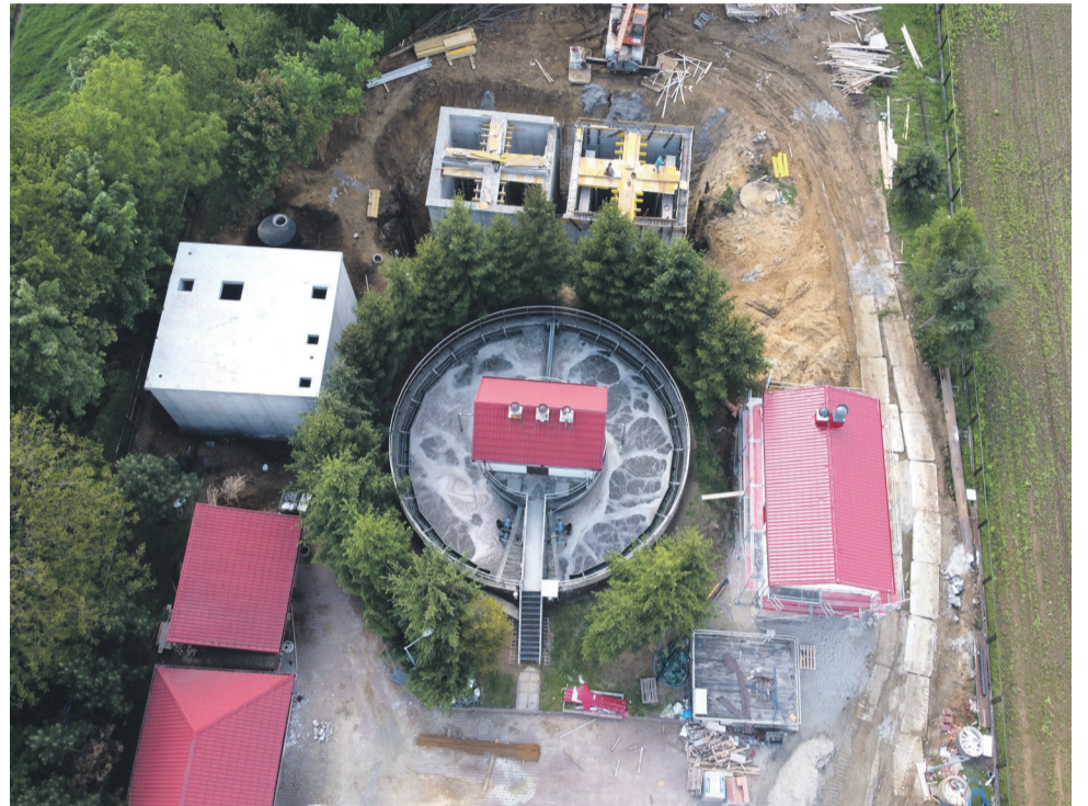
Modernizowana oczyszczalnia ścieków z lotu ptaka
