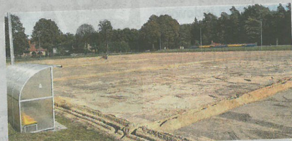
Prace na płycie stadionu.
