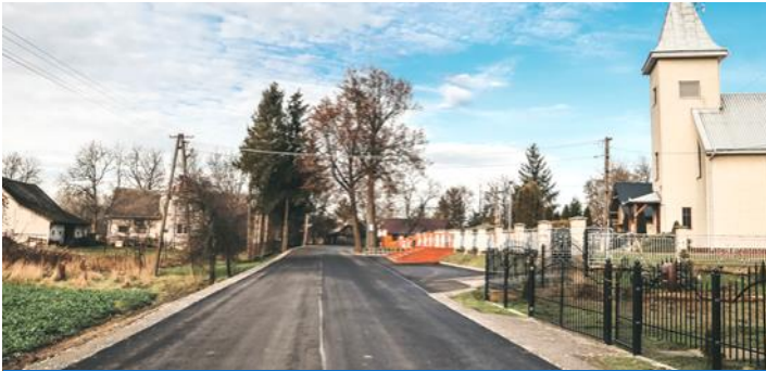
Remont drogi powiatowej w Głogowcu
