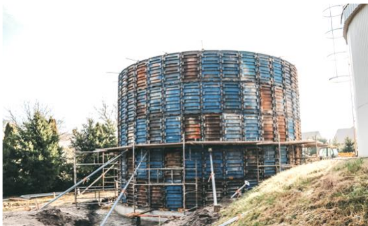
Budowa dodatkowego zbiornika na wodę
