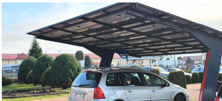
Carport przy Urzędzie Gminy
