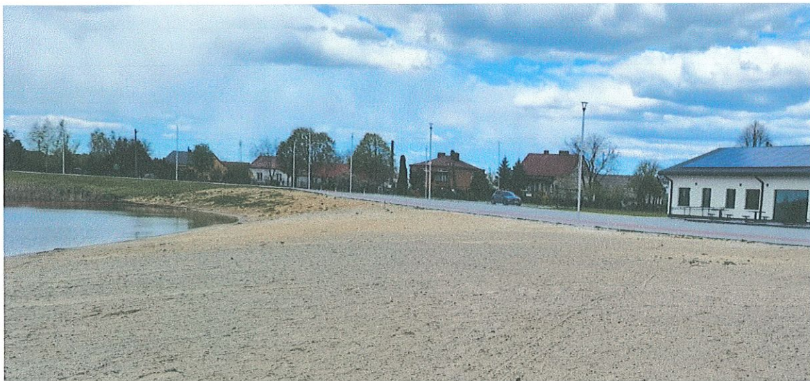
Zdjęcie 3 Kompleksu wodno-rekreacyjnego w Gniewczynie Łańcuckiej – budynek gastronomiczny
