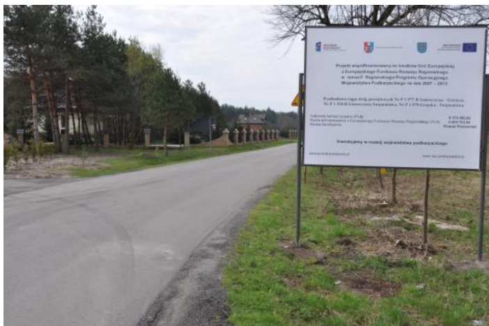
Przebudowa drogi w Gorzycach
