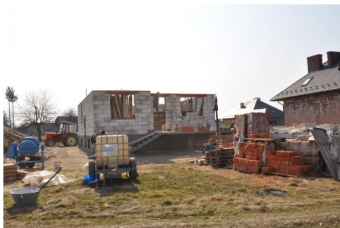
Kolejna budowa rozpoczęta
