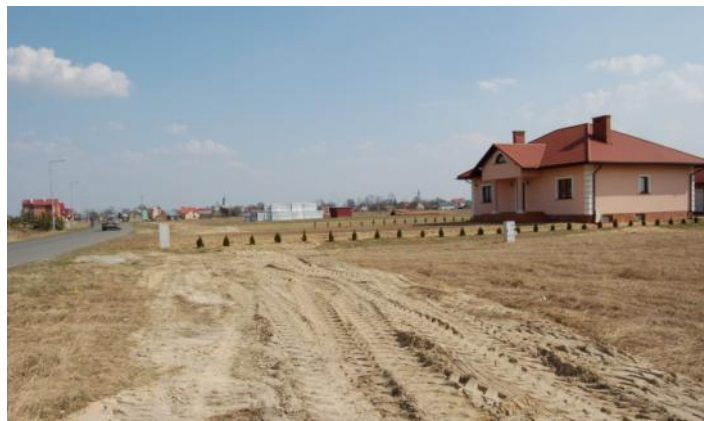
Wodociąg już gotowy
