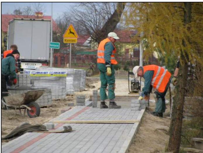
Budowa chodnika w Gorzycach
