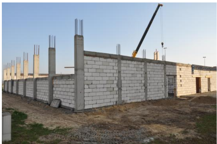
Ruszyła budowa sali gimnastycznej
