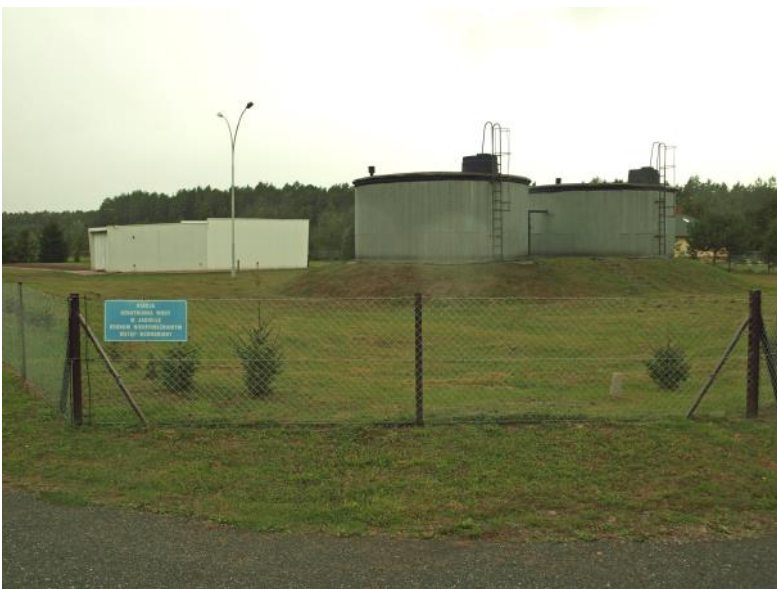
Ujęcie wody pitnej w Jagielle
