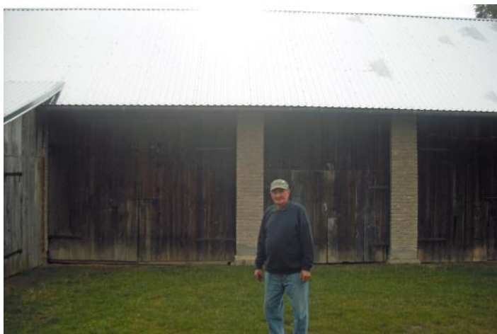
Wymieniony dach po usunięciu eternitu
