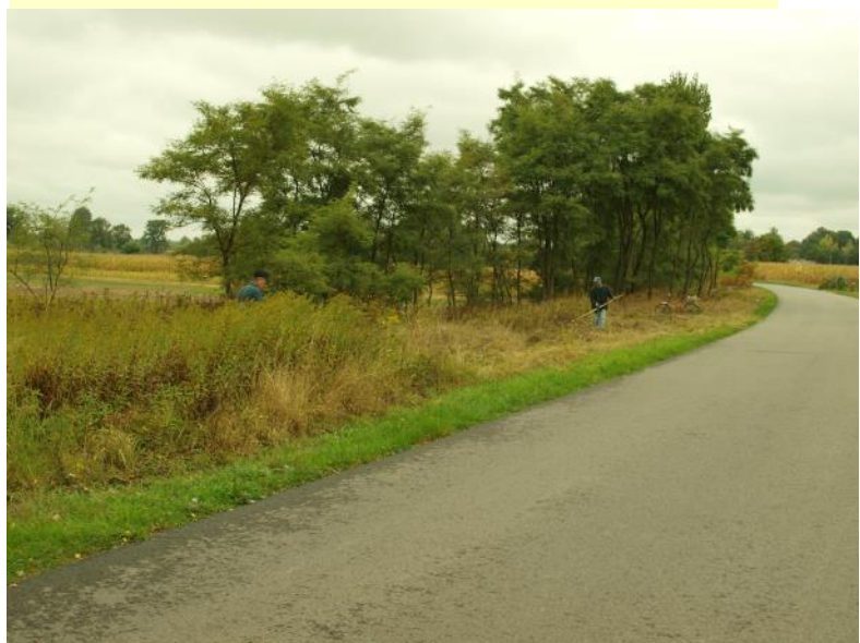
Prace przy porządkowaniu poboczy
