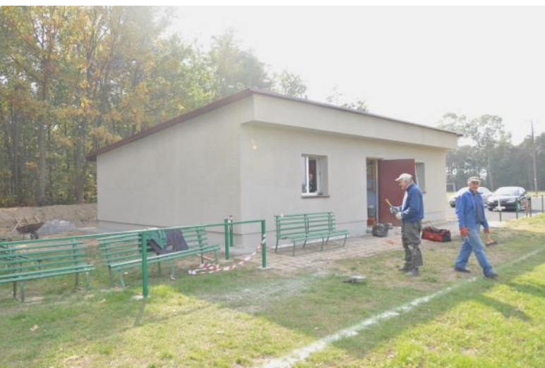
Prace przy budynku szatni „Wisłoczanki” Tryńcza
