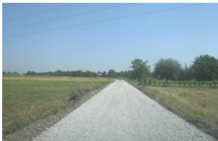
Droga gminna w drugiej linii zabudowy w Ubieszynie (FOGR)
