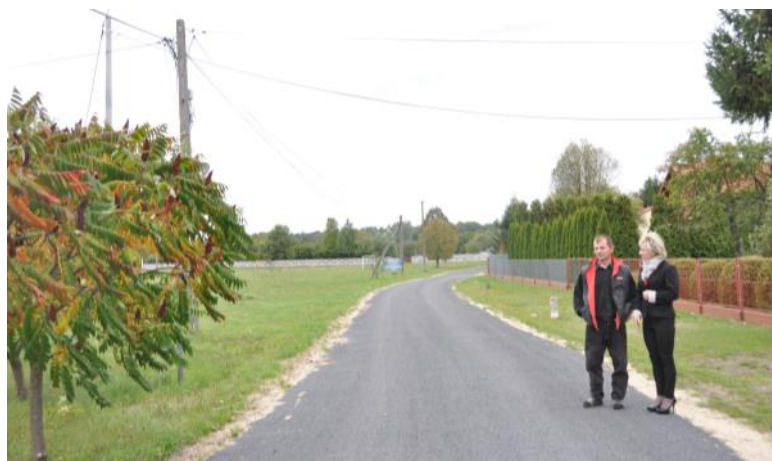
Droga gminna w Gorzycach po remoncie
