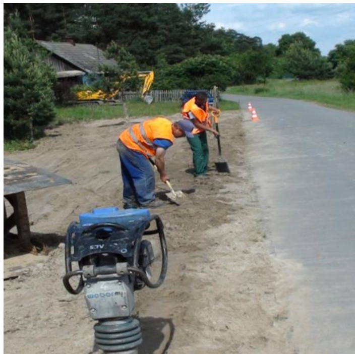
Prace przy ostatnim odcinku sieci kanalizacyjnej w Gniewczynie
