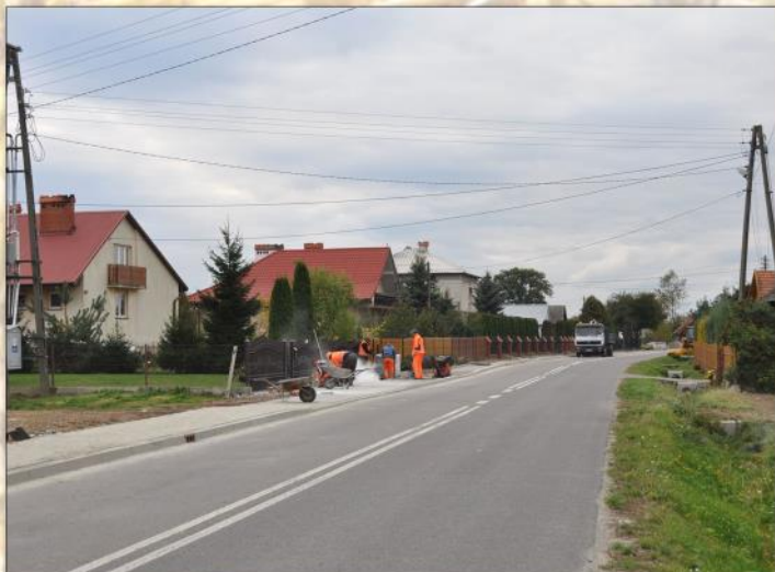
Gniewczyna Łańcucka – budowa chodnika na Zakręciu
