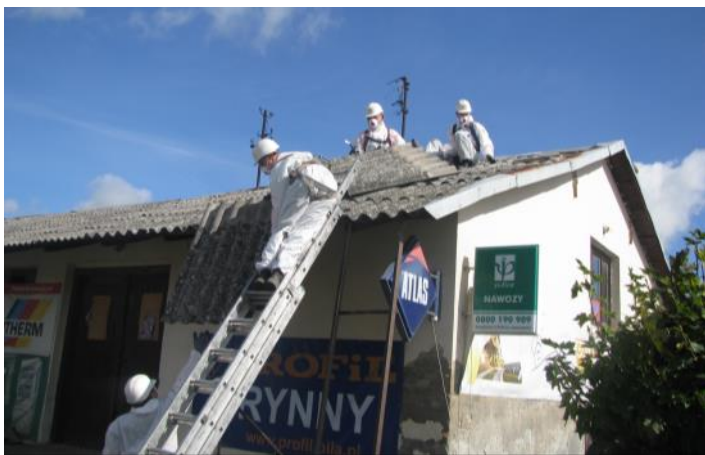
Demontaż płyt azbestowych
