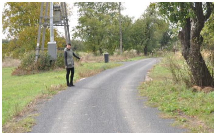
Droga gminna w Głogowcu po remoncie
