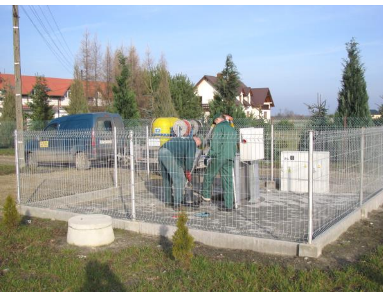
Usuwanie awarii pomp na przepompowni ścieków
