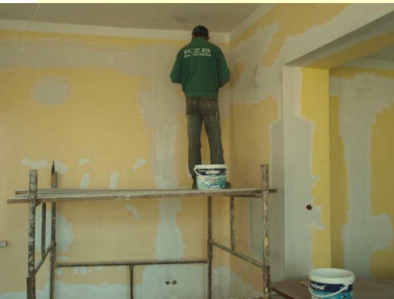
Remont pomieszczeń GOPS-u
