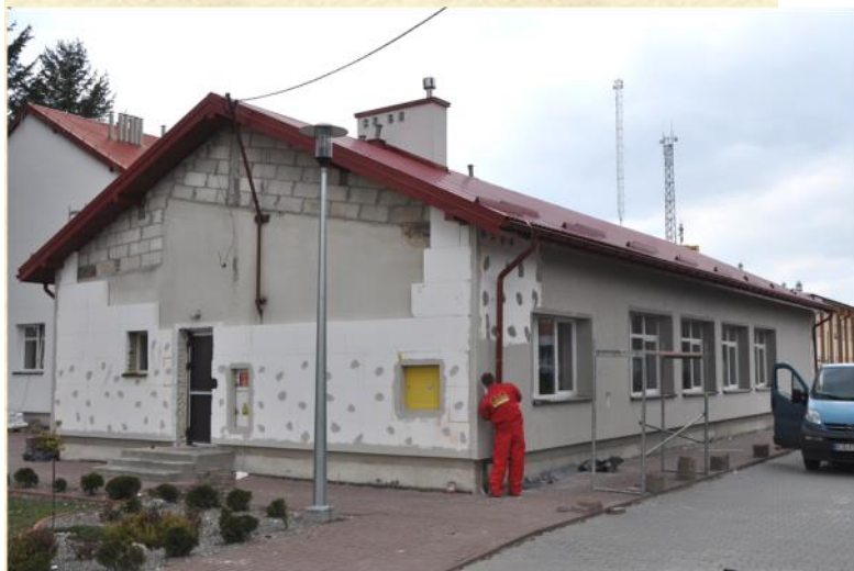
Dobudowany dach na budynku stołówki w szkole w Gorzycach
