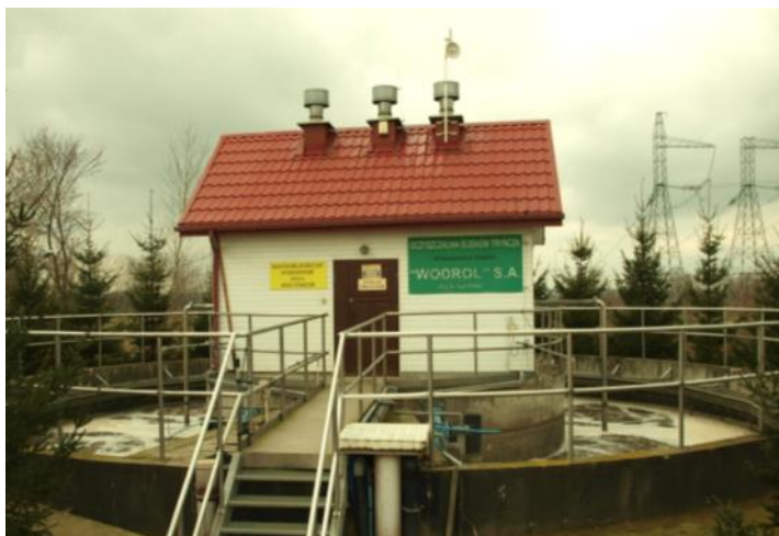
Oczyszczalnia ścieków w Tryńczy
