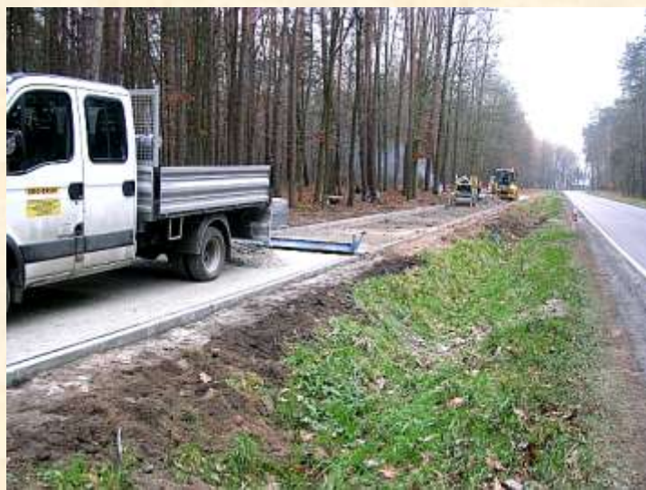
Prace przy budowie chodnika do Wólki Ogryzkowej
