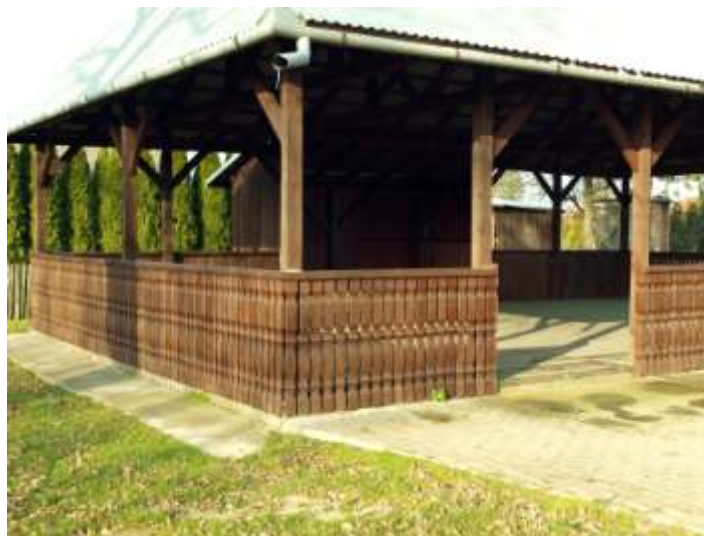
„Grzybek” taneczny w Ubieszynie po remoncie
