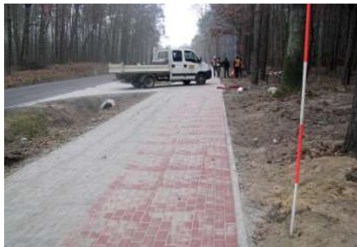
Prace przy budowie chodnika
