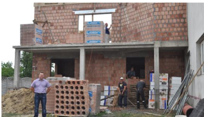
WDK w Jagielle w trakcie przebudowy
