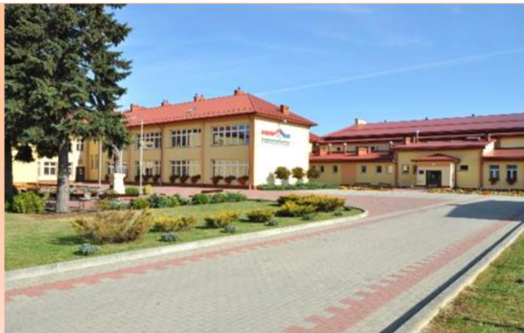
Budynek ZS w Tryńczy po przebudowie
