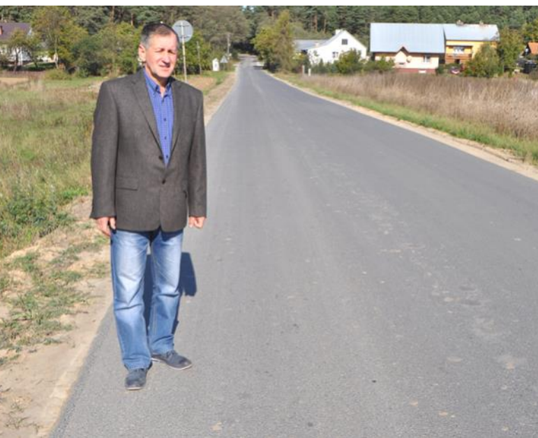
Stanisław Kogut na zmodernizowanej drodze.
