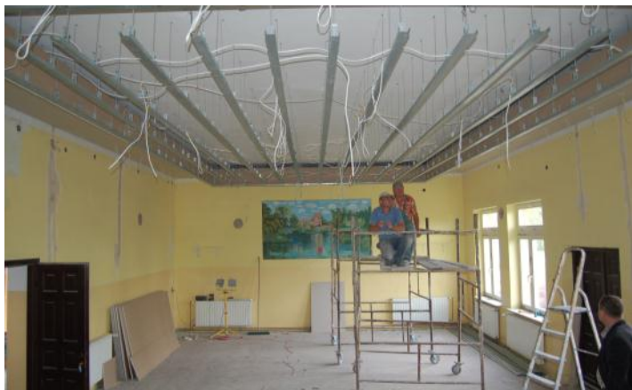
WDK w Wólce Małkowej w czasie prac remontowych
