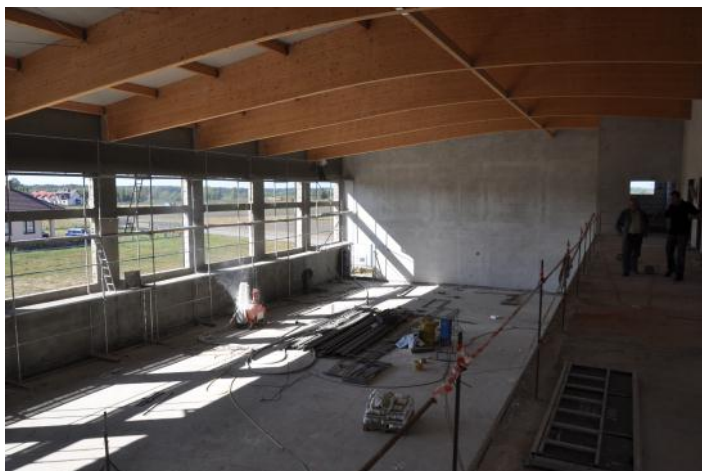
Sala w budowie
