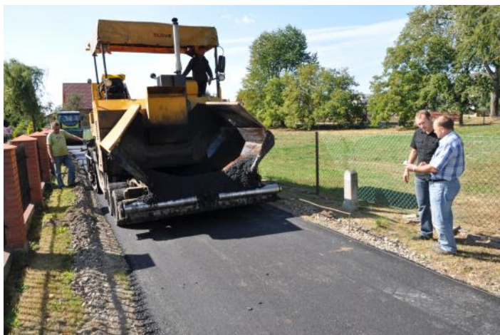
Prace przy budowie nowego odcinka drogi
