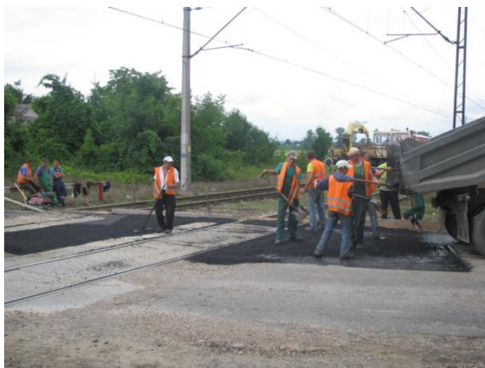
Układanie warstwy masy bitumicznej
