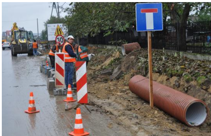
Roboty przy budowie kanalizacji
