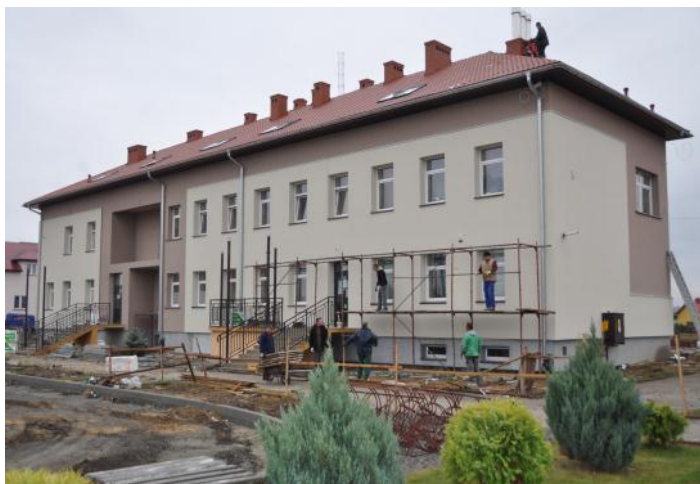
Budynek TCK z nowym dachem
