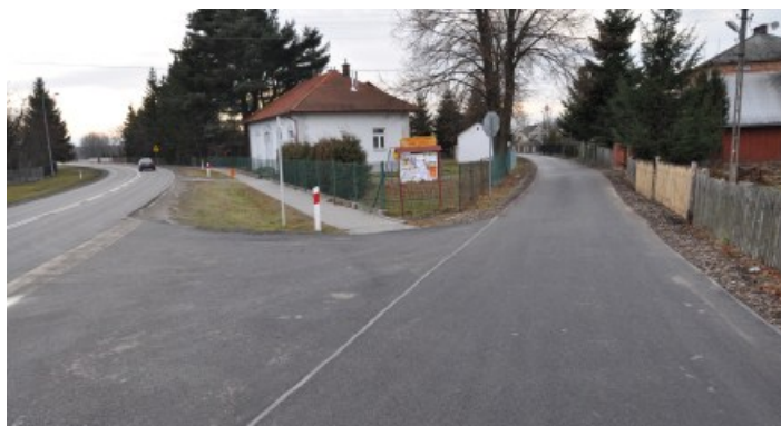
Wysfaltowany odcinek drogi w Wólce Małkowej
