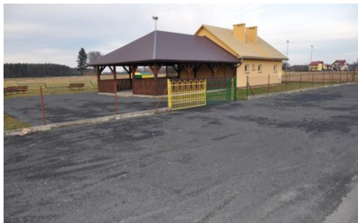
Wyremontowany plac przy szatni w Jagiellie
