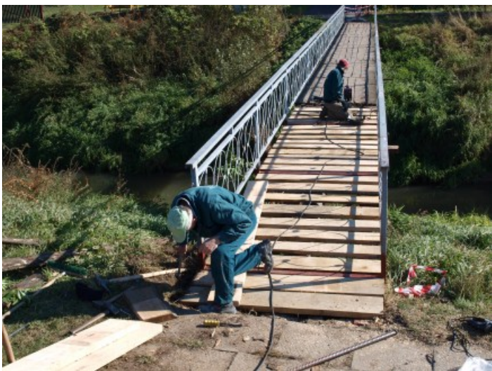
Remont kładki na rzece Mleczka
