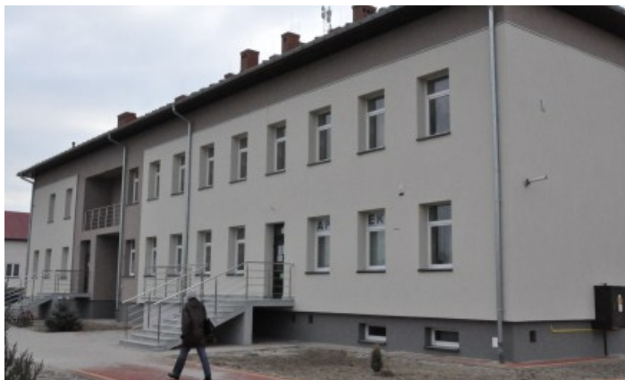
Budynek TCK po remoncie
