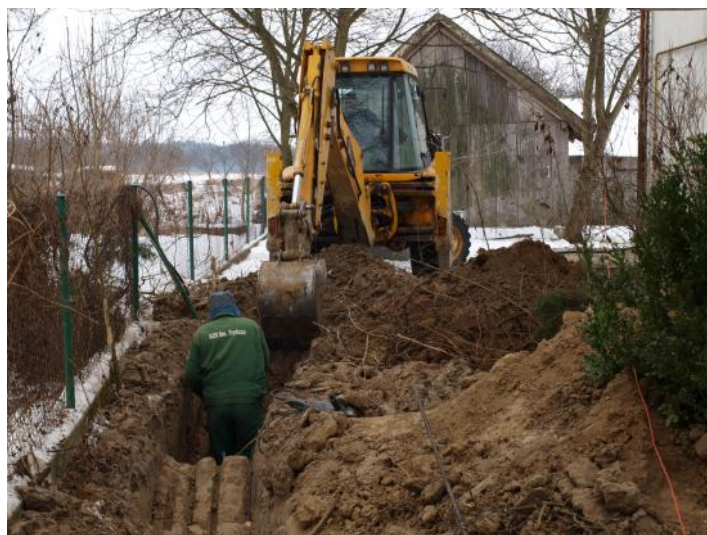
Wymiana zamrzniętego przyłącza
