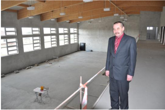
Zaawansowanie prac w hali w Gorzycach jest imponujące
