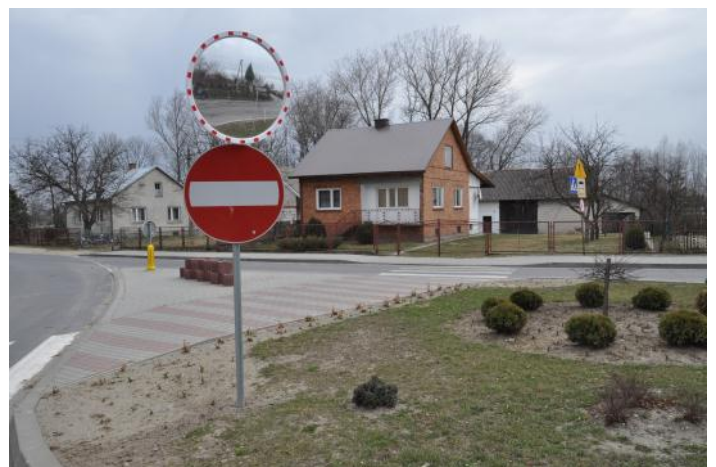
Wyremontowana droga w Gorzycach
