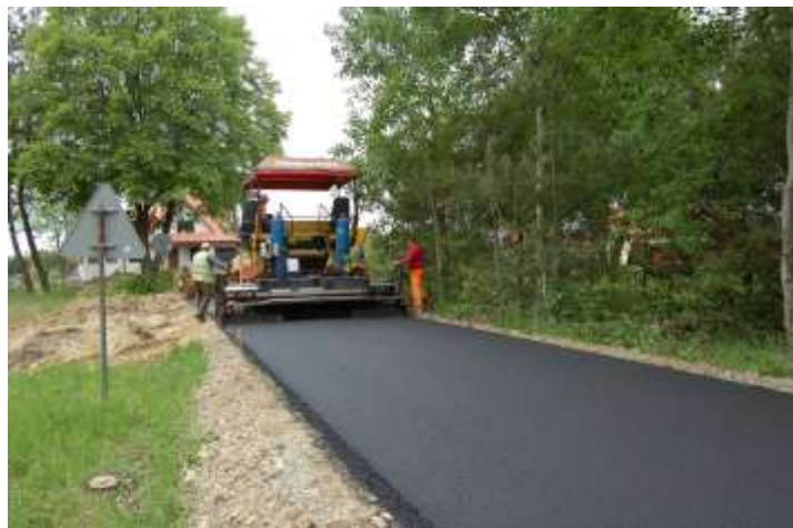
Nowy odcinek drogi w Gorzycach
