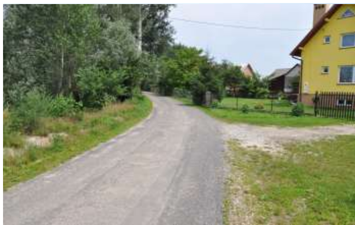
Droga przed remontem w Gniewczynie Łańcuckiej
