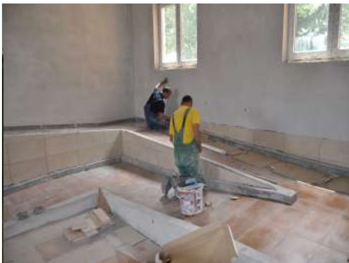
Prace przy podjeździe dla niepełnosprawnych
