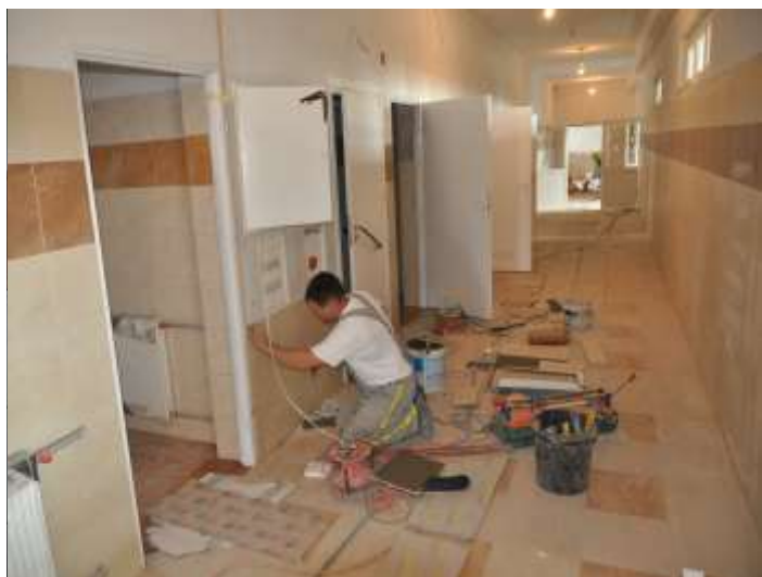
Układanie płytek na korytarzu nowej sali
