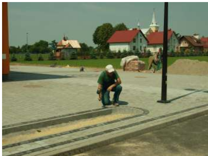
Pracownik KZB podczas układania kostki betonowej przy budynku remizy
