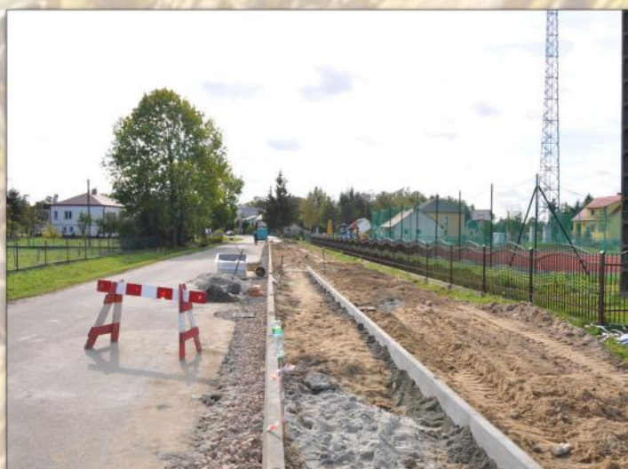
Budowa chodnika w Jagielle
