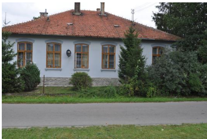
Odnowiona elewacja przedszkola i ogrodzenia
