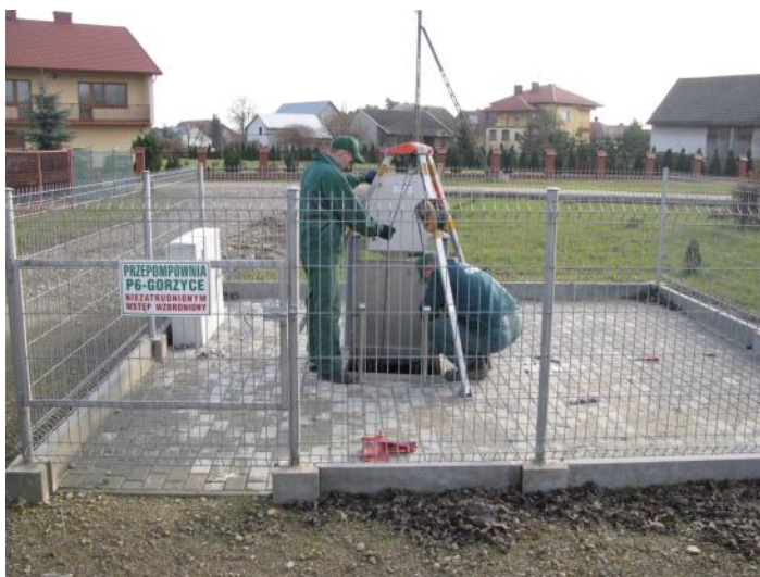
Czyszczenie przepompowni
