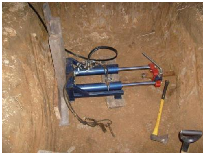
Nowe urządzenie do przepychu pod drogami
