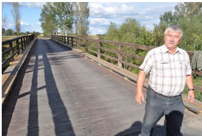
Sołtys Roman Kozyra na wyremontowanym moście
