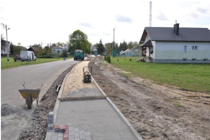
Budowa chodnika w Jagielle
