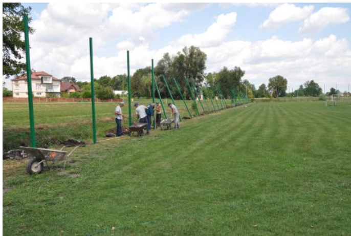
Montaż elementów ogrodzenia
