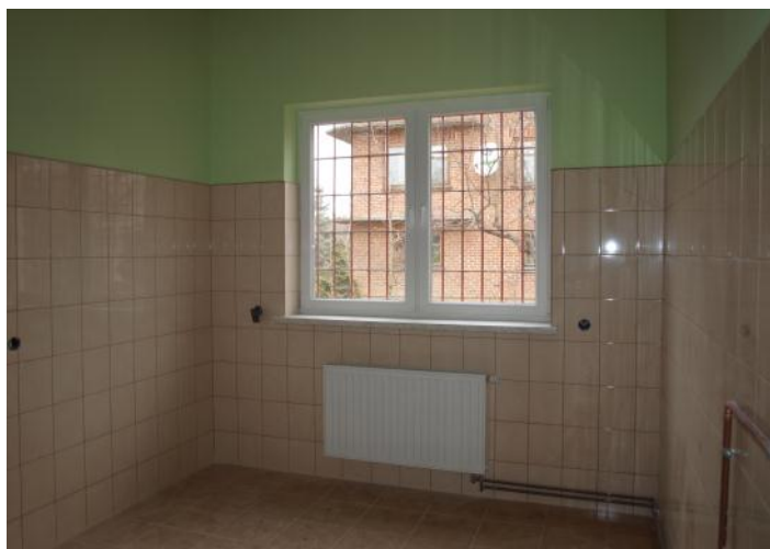
Odremontowana kuchnia w Głogowcu
