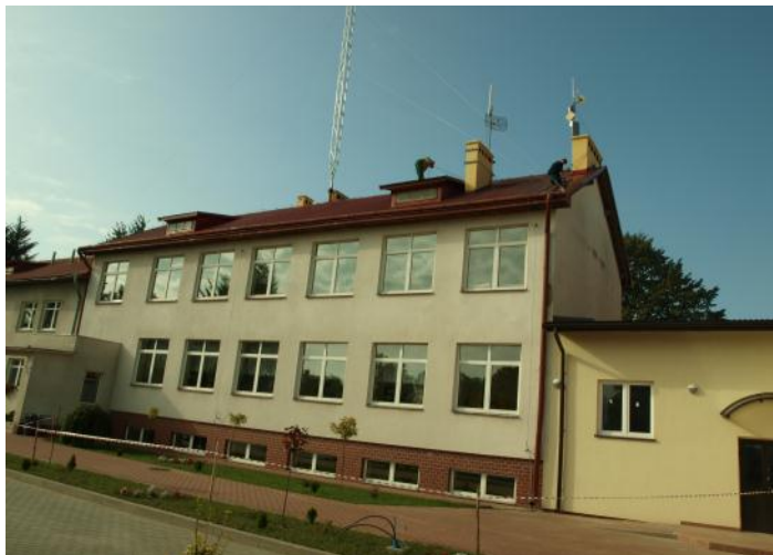
Malowanie dachu w Zespole Szkół w Gorzycach
