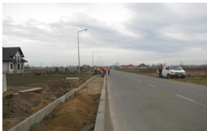
Budowa chodnika wzdłuż drogi powiatowej w kierunku Świętoniowej w Gniewczyźnie Łańcuckiej
