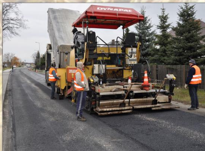
Remontowana droga w Gorzycach
