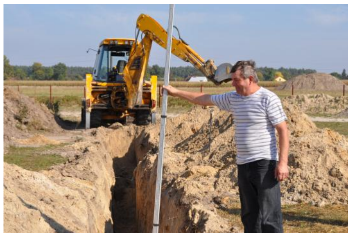
Budowa kanalizacji w Jagielle
