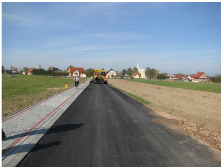
Roboty przy remoncie drogi w Tryńcy
