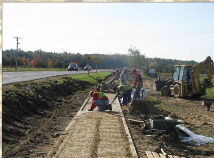
Budowa chodnika z Ubieszyna do ronda
