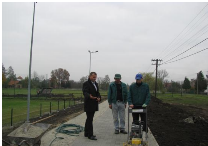
Roboty budowlane na stadionie LKS „San” Gorzyce
