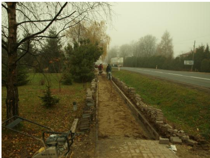
Remont chodnika w Ubieszynie
