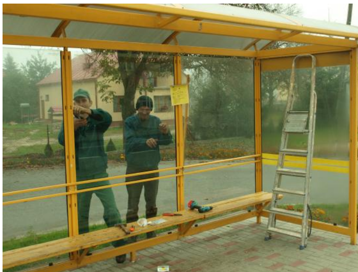
Wymiana rozbitych szyb na przystanku autobusowym
