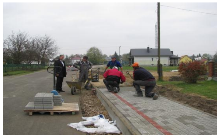
Budowa chodnika przy drodze powiatowej w Jagiellie
