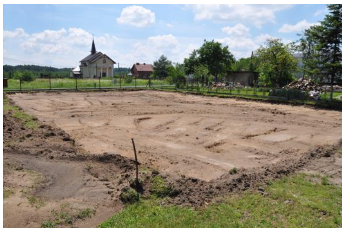
Teren przygotowany pod budowę nowego boiska
