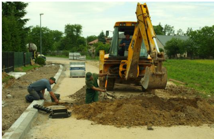
Wykonywanie odwodnienia na ul. 3 Maja w Tryńcy
