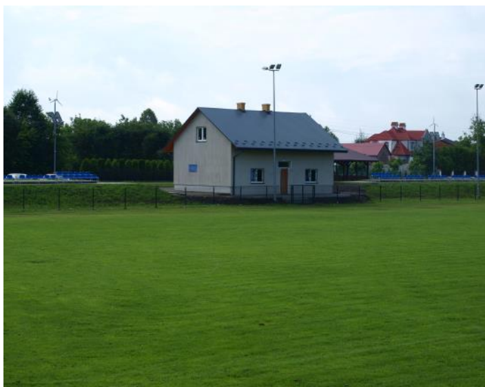
Stadion w Gorzycach po remoncie
