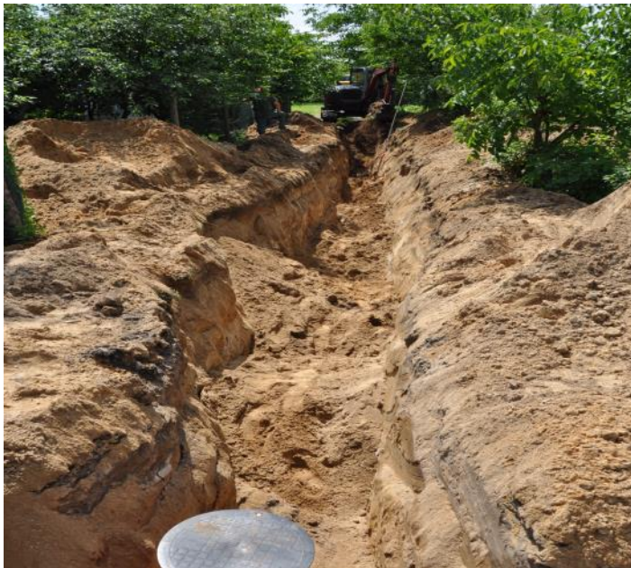
Budowa sieci kanalizacyjnej w Gniewczynie - Zawisłoczu
