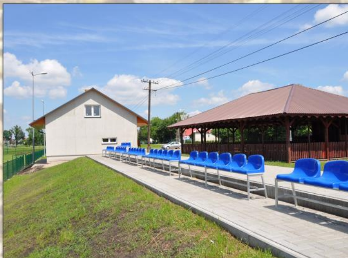
Gorzyce - stadion po modernizacji
