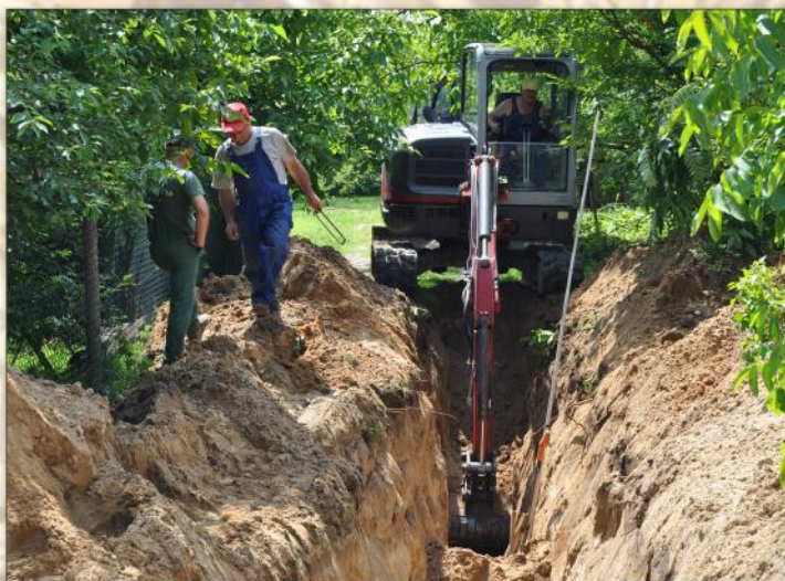
Gniewczyna Łańcucka - roboty przy kanalizacji
