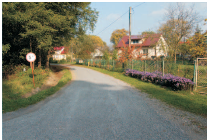
Tłuczniowa droga dojazdowa w Wólce Ogryzkowej
