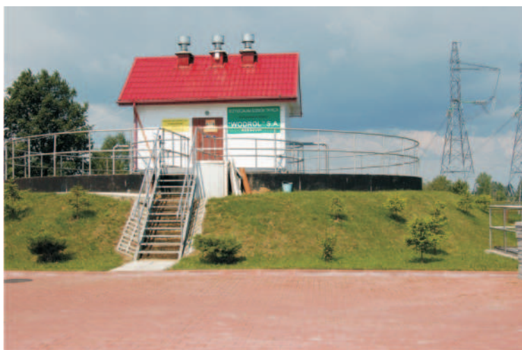
Oczyszczalnia ścieków w Tryńcy
