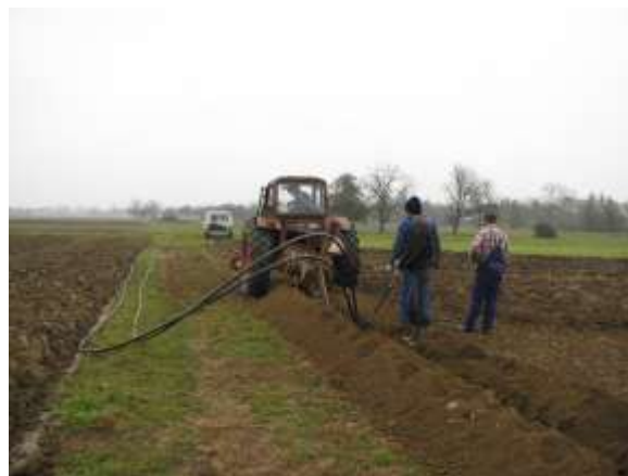
Prace przy budowie światłowodu w Ubieszynie.
