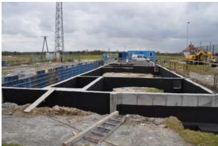
Niech się mury pną do góry ! - Rozpoczęta budowa Sali gimnastycznej w Gorzycach
