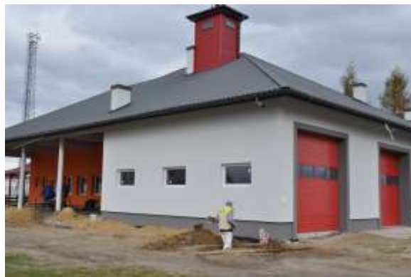
Remiza OSP w Trynczę - już widoczne są efekty remontu
