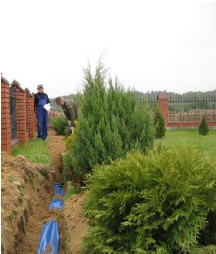
Prace przy budowie oświetlenia w Wólce Małkowej
