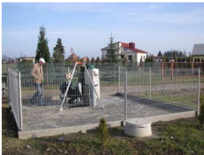
Sieć kanalizacyjna wymaga stałej kontroli i konserwacji
