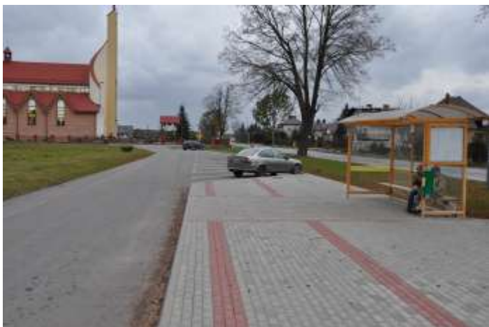
Zatoka autobusowa w Gorzycach
