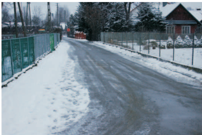
Drogi gminne też będą przejezdne
