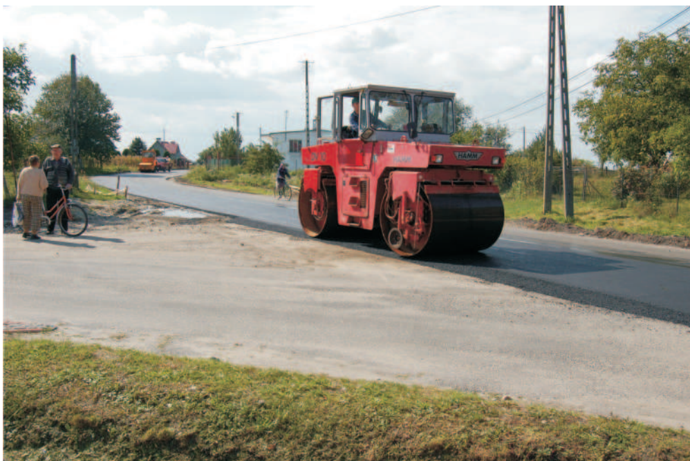
Remont drogi powiatowej
