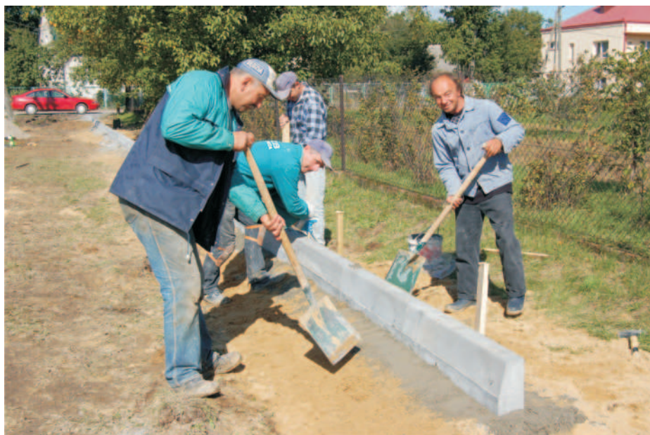
Prace przy parkingu
