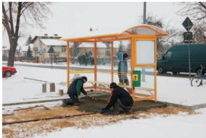
Budowa wiaty przystankowej w Gorzycach
