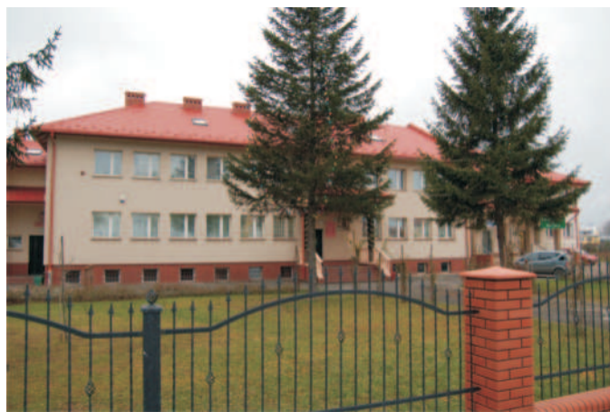
Budynek Urzędu Gminy z nowym dachem
